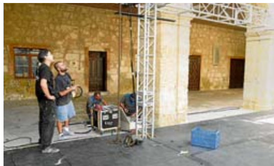
Trabajos de instalación y electricidad en el patio de Los Sitios./FOTOS:CASAMAR
